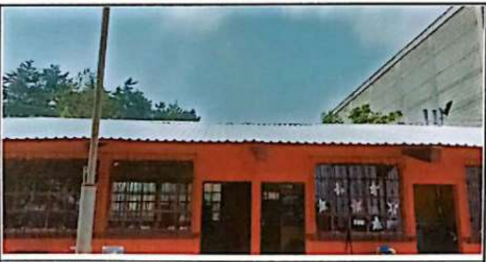
Foto 5: Sustitución de lámina
