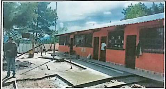
Foto 2: Mantenimiento de piso de concreto
