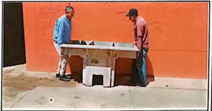
Foto 6: Sustitución de pila de dos lavaderos
