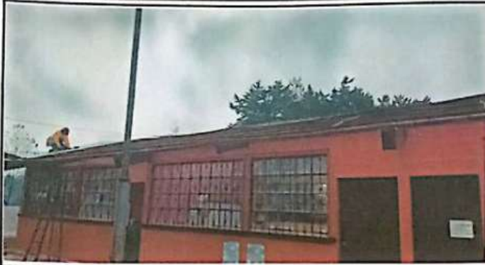
Foto 1: Sustitución de lámina
