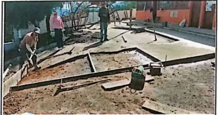
Foto 4: Reparación de piso de concreto
