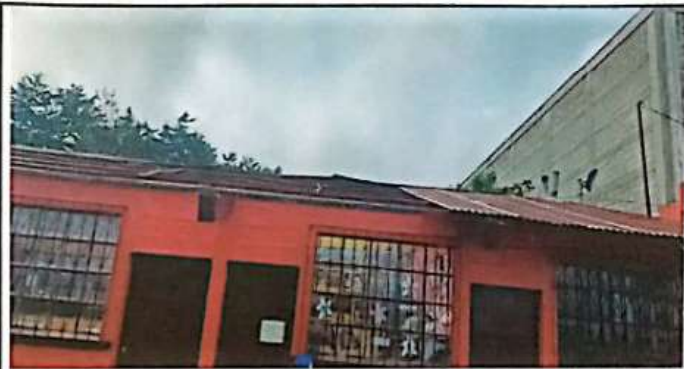
Foto 3: Sustitución de lámina
